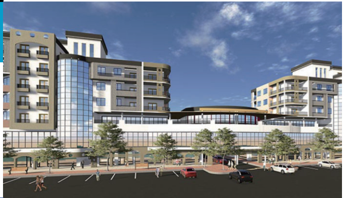
Nákupní centrum Les-Salines v Alžírsku, celkový výkon VRF 1000 kW.
