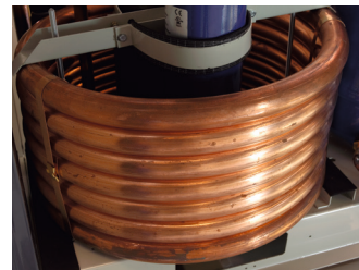
Doplnkový vodou chladený kondenzátor
