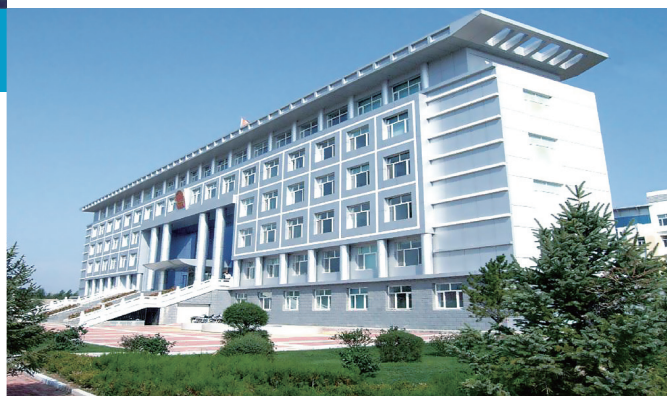
Budova vlády v Číne.
