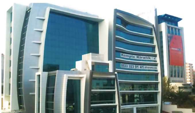
Kancelářská budova v Istanbulu, Turecko.
